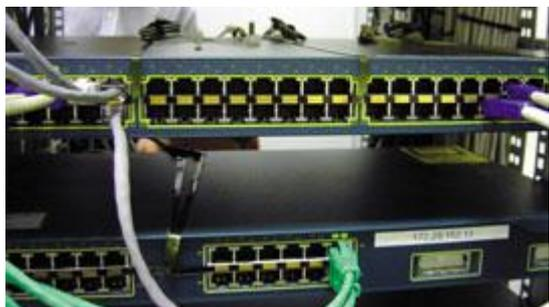
Рис. 8. Сенсорные панели iTRACS на активном сетевом оборудовании.
