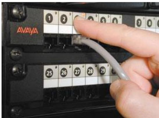
Рис. 5. Коммутационная панель iPatch оснащена кнопками для включения индикаторов и замыкания контактов.
